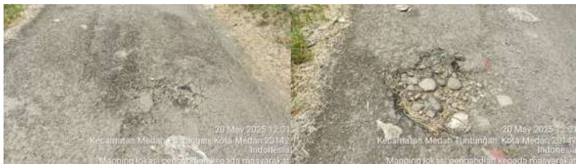
Gambar 3. Ukuran Lubang Jalan yang Tidak Sama
