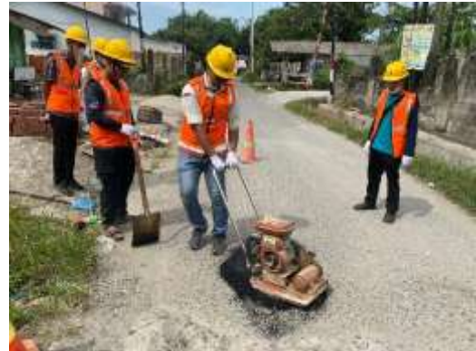
Gambar 12. Pemadatan Material Aspal dengan Stamper
