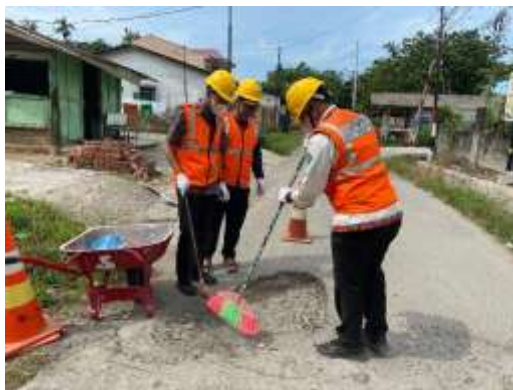
Gambar 9. Pembersihan Lubang
