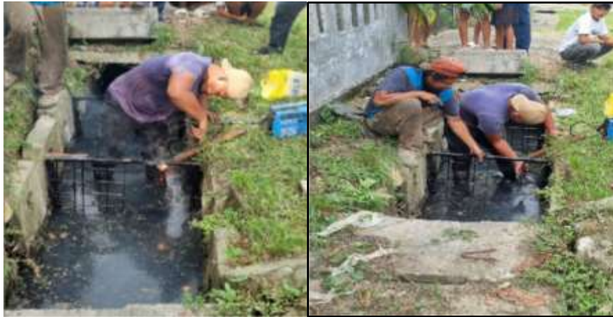
Gambar 3. Tahap Pelaksanaan dan Pemasangan Jaring/ Trash Rack pada Drainase
