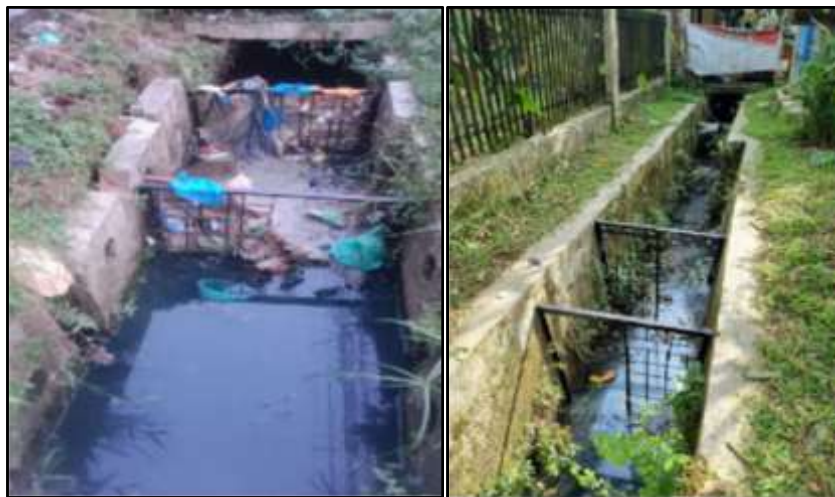
Gambar 4. Tahap Pemasangan Jaring/ Trash Rack pada Drainase
