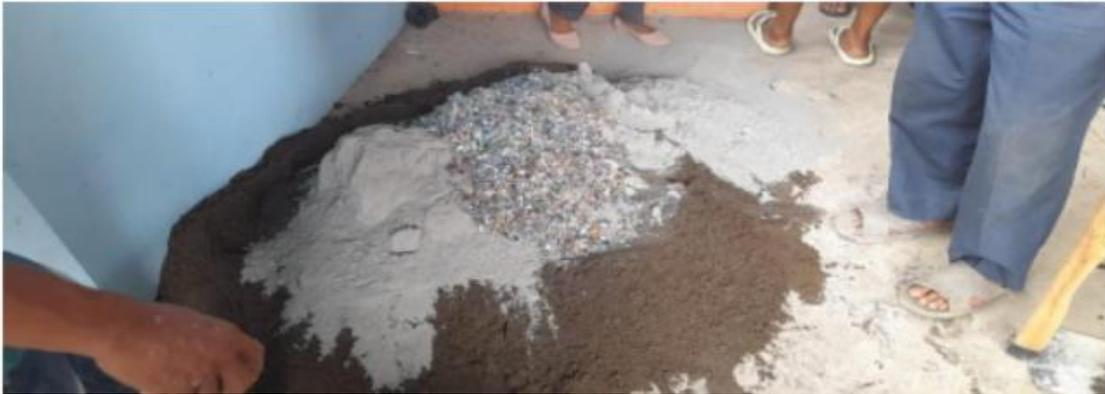
**Gambar 5.** Proses Pembuatan Batako yang Telah Dicampur dengan Sampah Plastik yang Telah Dicacah
